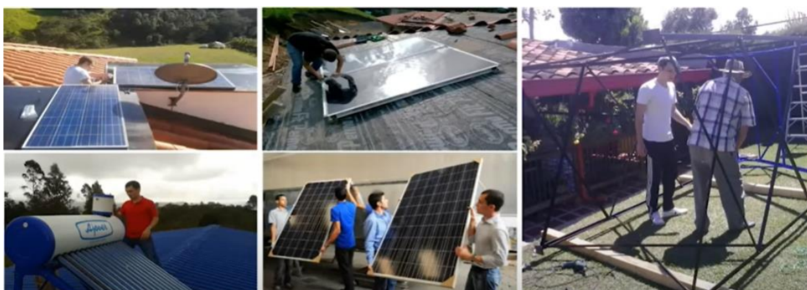
Imagen 1. Instalación de equipos. Fuente: material Erco Energía
